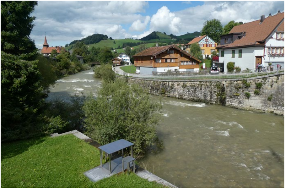
Panorama z mostu na północ, w tle kościół reformowany
