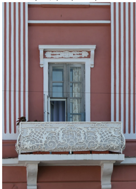
Balkon kamienicy nr 10, w pierzei południowej
