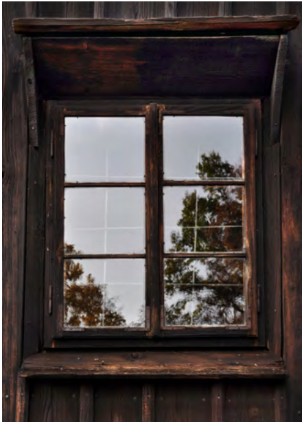
Okno w nawie, elewacja południowa
