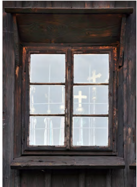
Okno w nawie, elewacja północna
