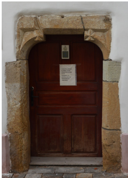
Gotycki portal klasztoru (elewacja zachodnia)
