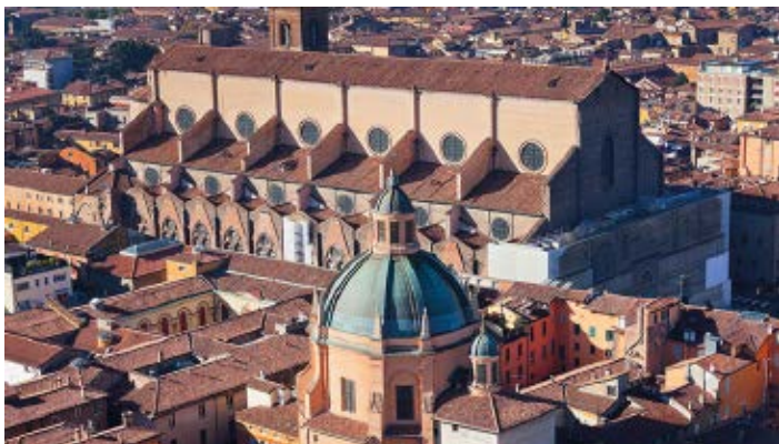
▲ Bazylika św. Petroniusza – wznoszona od 1390 r., do dziś nieukończona
