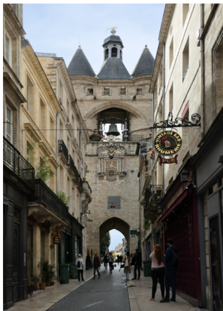
Elewacja północna (od rue Saint James)
