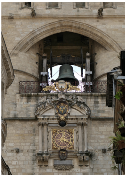
Elewacja północna (od rue Saint James)
