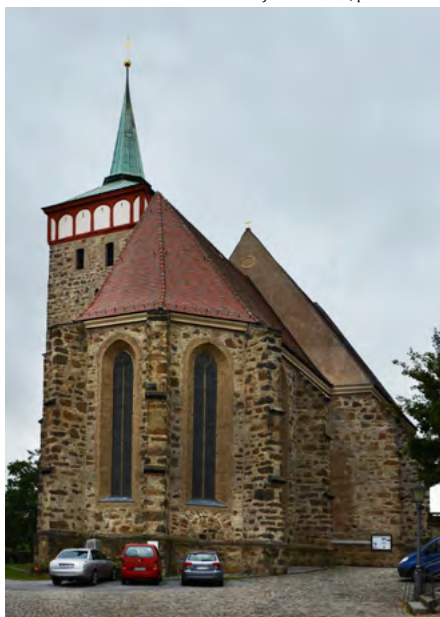
Elewacja wschodnia, prezbiterium
