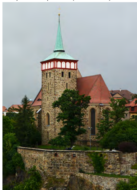
Elewacja wschodnia i południowa (z Friedensbrücke)
