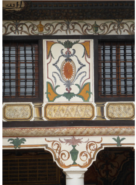
Detale elewacji północnej
