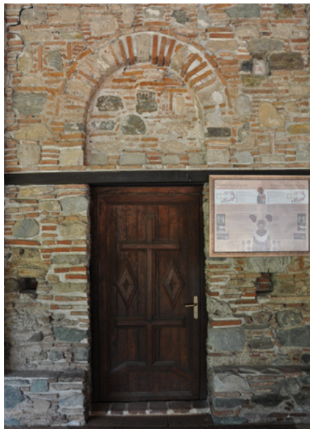
Elewacja południowa, wejście do przednawia
