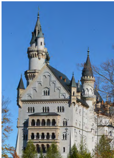
Elewacja zachodnia pałacu, z wykuszem
