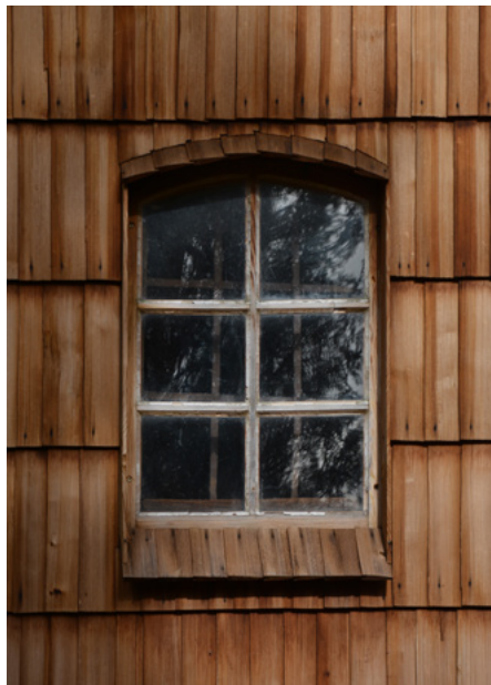
Okno w nawie (elewacja południowa)
