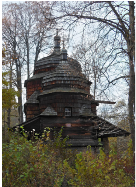
Elewacja wschodnia, prezbiterium
