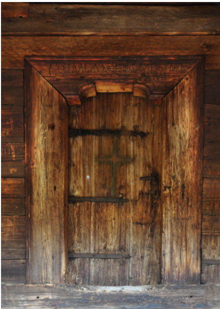
Drzwi do kruchty z ozdobnymi okuciami (elewacja zachodnia)
