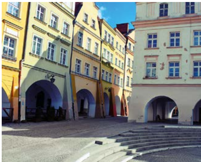
▲ Jelenia Góra, kamienice podcieniowe przy rynku
