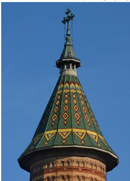
Wieża centralna (nad nawą), od północy
