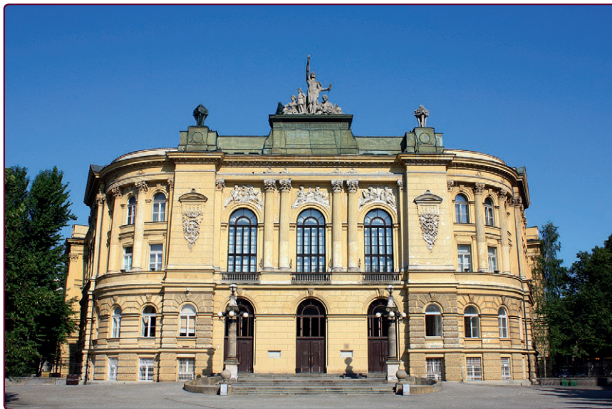
Budynek główny Politechniki Warszawskiej
