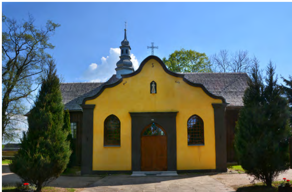
Elewacja północna, murowana kaplica z 1869 r.
