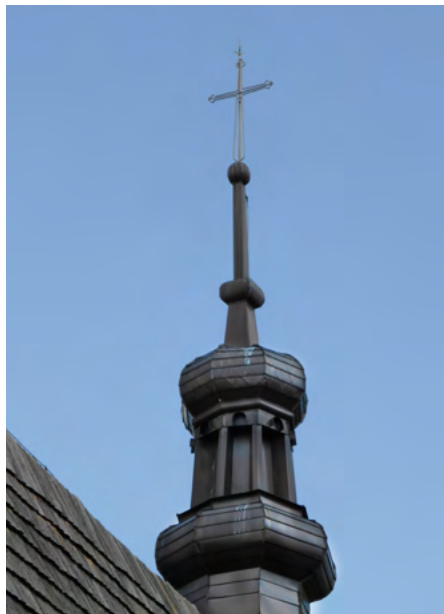
Sygnaturka, elewacja południowa
